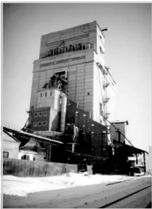
Элеватор Новосибирского мелькомбината №2. Видна кирпичная несущая стена, оставшаяся от мельницы Туркиных
