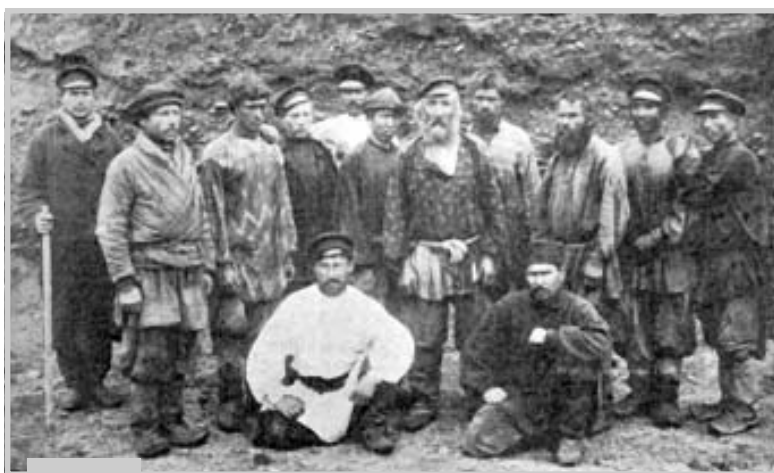
Рабочие-строители Транссибирской магистрали
