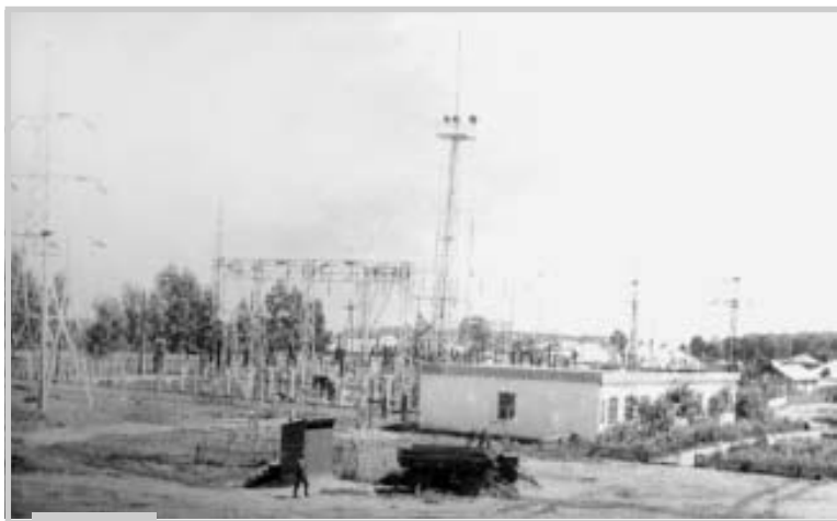
Подстанция в районе
