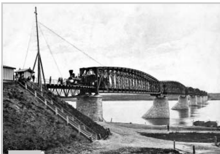
Мост через Обь. 1897 г.
