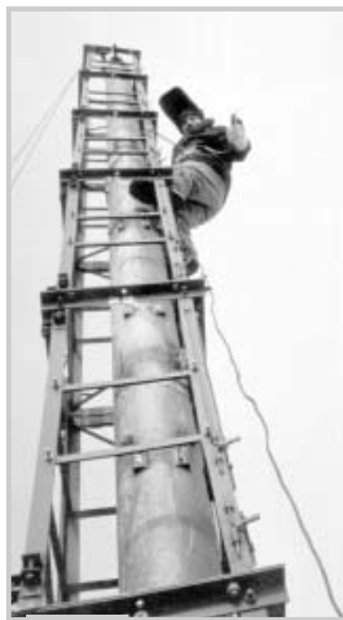
Монтаж телевизионной вышки
