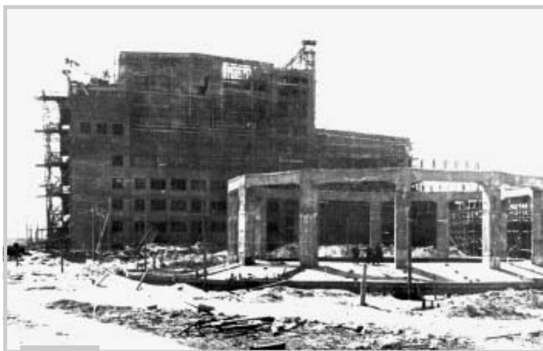
На строительстве Новосибирской ТЭЦ-2. 1933 г.
