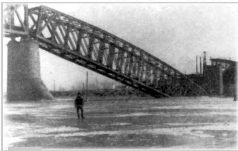
Разрушенный мост через Иртыш
