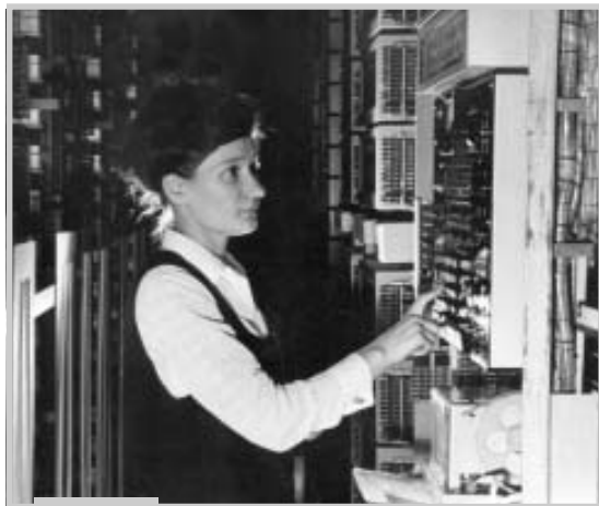
Автозал на центральном телефонном узле
